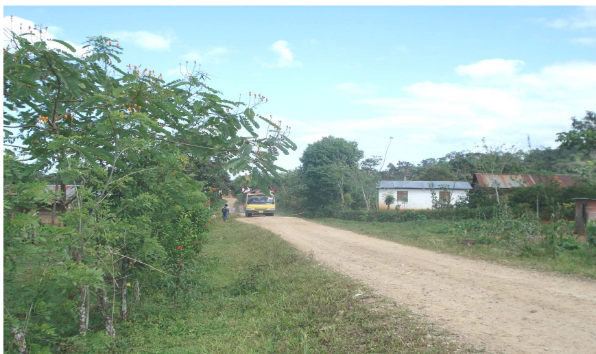
Figura 3 Vista de frente, de la carretera con la que cuenta la comunidad.
