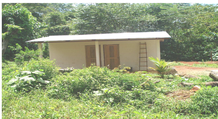
Figura 29 Construcción de viviendas, proyecto ejecutado por FOGUAVI, en la comunidad Rocja Uchil, Cobán, A.V.
