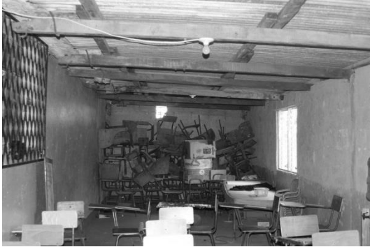
9-.Aula de sexto primaria utilizada de bodega.
