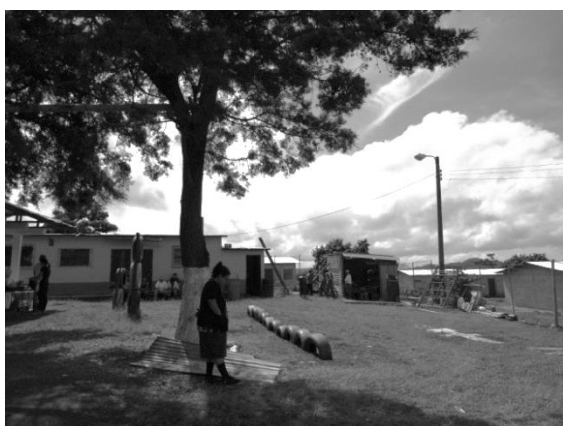
5-. Vista del Centro de Salud sin funcionamiento.
