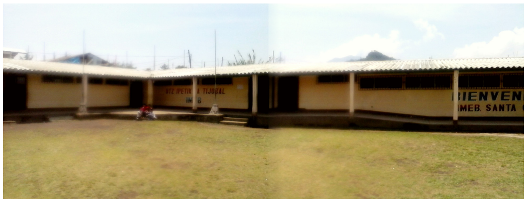
Modulo de Aulas a demoler para la construcción del auditorio.
