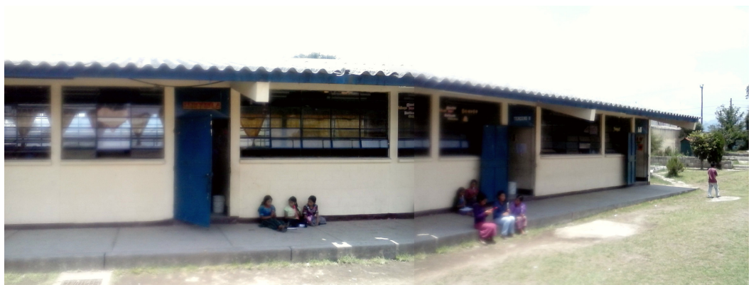
Aulas a renovar para uso de talleres.
