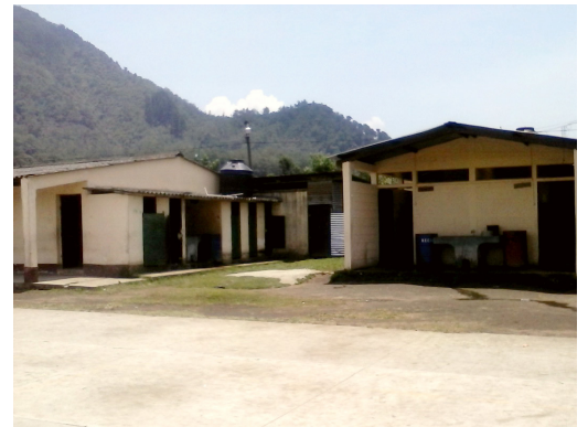
Administración y Servicios Sanitarios.
