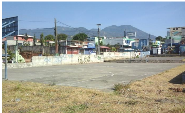
Fotografía No. 5 Lado interior Noroeste, se aprecia una de dos canchas de básquet ball existentes. (Fuente propia)
