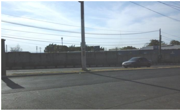
Fotografía No. 1 Lado exterior Oeste, se observa calzada de ingreso del municipio. (Fuente propia)
