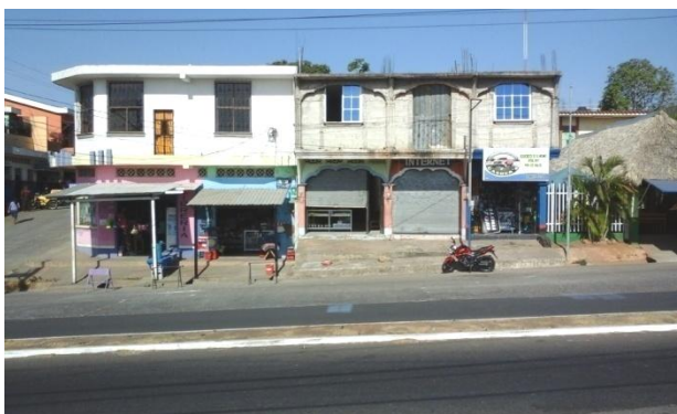
Fotografía No. 7 Vista exterior Oeste, se observan locales comerciales y la calzada de ingreso del municipio. (Fuente propia)
