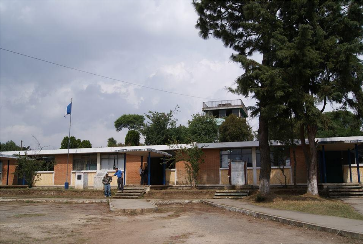
2.5.3 Granja de Rehabilitación de Cantel. Occidente de Guatemala.
