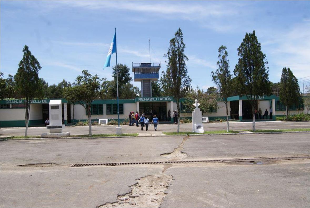
2.5.5 Granja de Rehabilitación Pavón. Centro de Guatemala.
