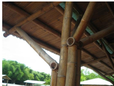
Descripción: Uniones de columnas y tijeras estructurales, de bambú. Fotografía: Aníbal Rodríguez, 11 de septiembre 2013.
