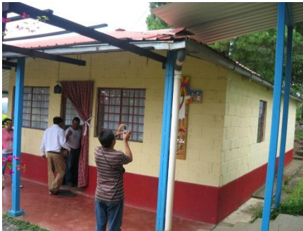
Descripción: Viviendas. Fotografía: Aníbal Rodríguez, 31 de agosto 2013.
