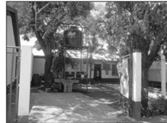
F-2 Terreno del proyecto actualmente Centro de Salud que será demolido.
