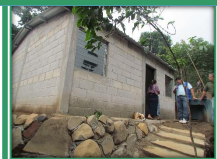
FOTOGRAFIA 31 VIVIENDA BENEFICIARIO DE CARITAS, BUENA VISTA SAN MARTIN SACATEPEQUEZ, QUETZALTENANGO FUENTE: ALONDRA GUZMAN FECHA: 24/6/14
