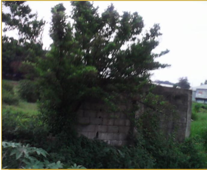
FOTOGRAFIA No. 21. Infraestructura existente, edificación antigua de mampostería.
