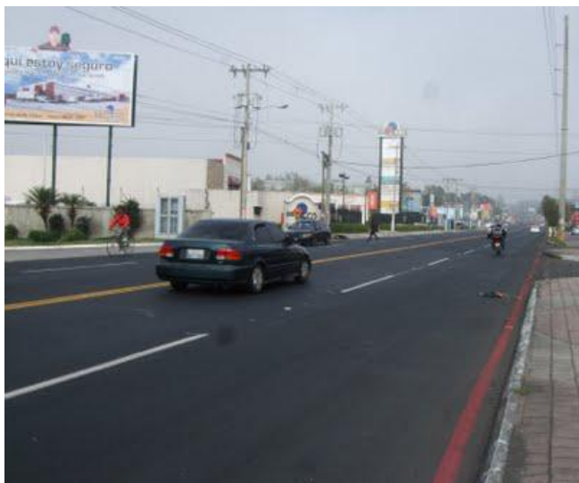
FOTOGRAFIA No. 15. Carretera que va de San Miguel Petapa hacia Villa Nueva, asfaltada en buen estado.
