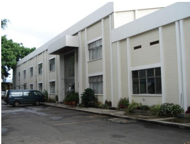
Ilustración 24 Fachada frontal; fuente: Propia junio 2012
