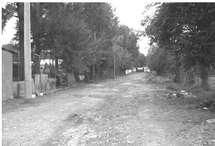
Vista hacia el Norte de la 1era. Avenida
