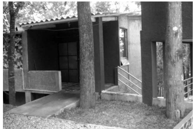
Ingreso a módulo de dormitorio
