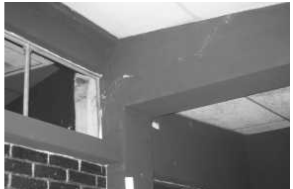
Paredes y vigas agrietadas.
