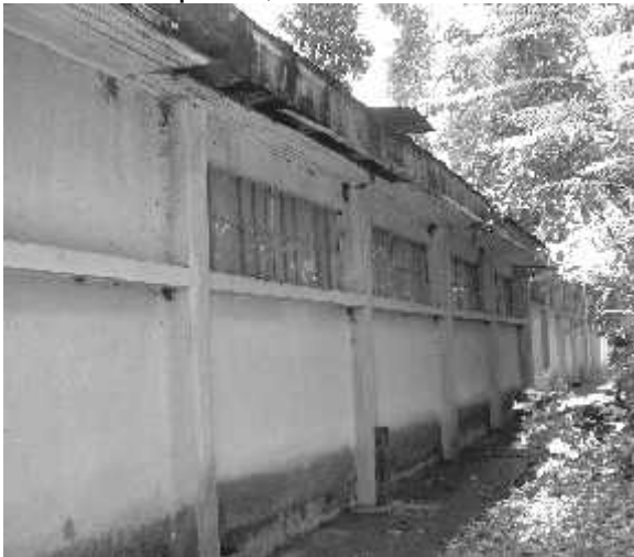
Aquí se puede apreciar otro corredor que une a los salones en el cual se utilizó losa plana, columnas de concreto.
