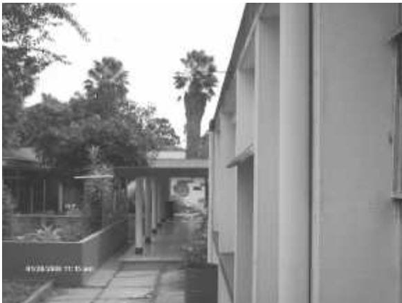
Aquí se puede apreciar otro corredor que une a los salones en el cual se utilizó losa plana, columnas de concreto.
