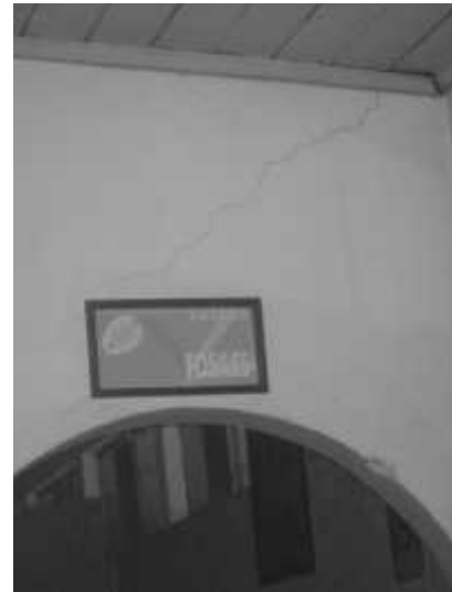
Paredes y vigas agrietadas.
