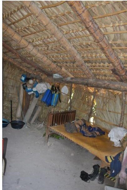
Figura 48 Tipología de vivienda vernácula, materiales, madera, hoja de palma, vista interior. Fotografía de edaso (Caserío El Coco, Municipio de San Juan Ermita, Chiquimula 2015)
