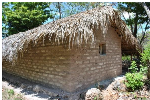
Figura 57 Tipología de vivienda construida con: cimiento de piedra, adobe, madera, y cubierta de palma. Fotografía de edaso (Caserío El Coco, Municipio de San Juan Ermita, Chiquimula 2015)
