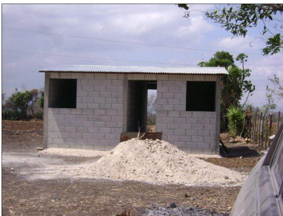
Figura 67 Vivienda tipo Fopavi. Fotografía de http://www.google.com.gt 2015
