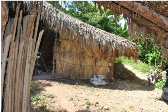
Figura 47 Tipología de vivienda vernácula, materiales madera, hoja de palma, vista lateral. Fotografía de edaso (Caserío el Coco, Municipio de San Juan Ermita, Chiquimula 2015)
