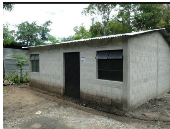
Figura 68 Vivienda tipo Fopavi. Fotografía de http://www.google.com.gt 2015
