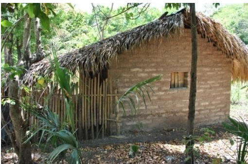
Figura 58 Tipología de vivienda construida con: cimiento de piedra, adobe, madera, y cubierta de palma. Fotografía de edaso (Caserío El Coco, Municipio de San Juan Ermita, Chiquimula 2015)
