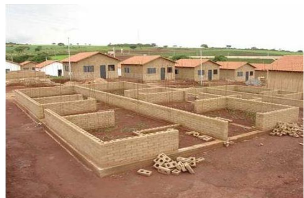
Figura 84 Construcción de viviendas con ladrillo ecológico. Fotografía de http://www.sistemasdeconstruccionecologicos.com/ladrilloecologicos.htm (Buenos Aires Argentina 2011)
