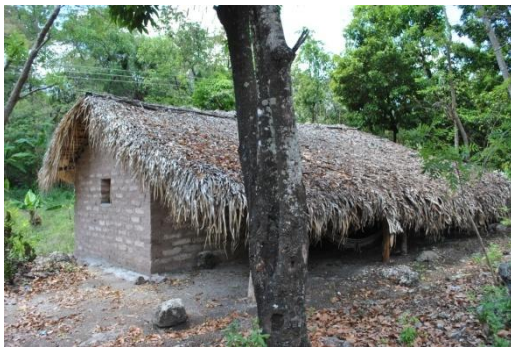
Figura 56 Tipología de vivienda construida con: cimiento de piedra, adobe, madera, y cubierta de palma. Fotografía de edaso (Caserío El Coco, Municipio de San Juan Ermita, Chiquimula 2015)
