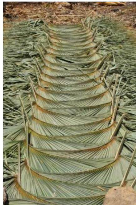
Figura 12 Proceso de secado de palma para ser utilizado en cubierta. Fotografía edaso (Caserío El Coco, Municipio de San Juan Ermita, Chiquimula 2015)
