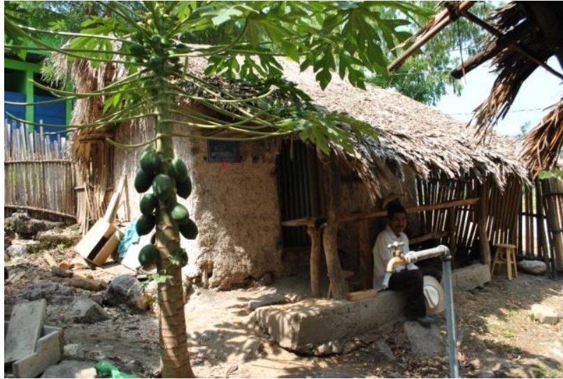
Figura 14 Vivienda vernácula, sistema constructivo bajareque, madera y palma. Fotografía de edaso (Caserío El Coco, Municipio de San Juan ermita, Chiquimula 2015)
