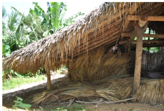
Figura 50 Tipología de vivienda vernácula, materiales, madera, hoja de palma, vista lateral. Fotografía de edaso (Caserío El Coco, Municipio de San Juan Ermita, Chiquimula)
