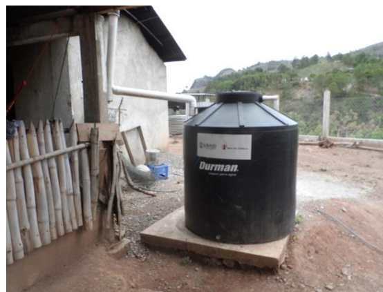
Figuras 87,88, Sistema de Captación de Agua de Lluvia Fotografía de edaso (Aldea Minas Arriba, Municipio de San Juan Ermita, Chiquimula 2015)
