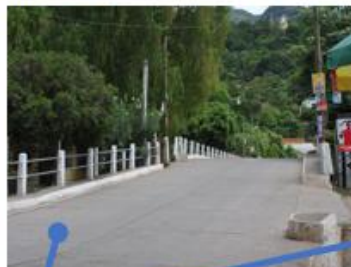
Fotografía No.5 Puente de Ingreso Principal, Municipio de S.J. Ermita
