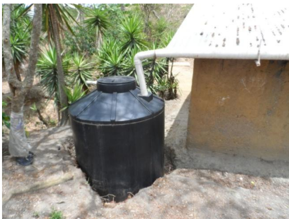
Figuras 87,88, Sistema de Captación de Agua de Lluvia Fotografía de edaso (Aldea Minas Arriba, Municipio de San Juan Ermita, Chiquimula 2015)
