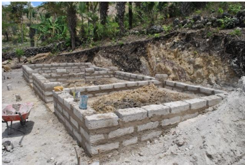
Figura 13 Sistema constructivo de adobe. Fotografía de edaso (caserío El Coco, Municipio de San Juan Ermita, Chiquimula 2015)
