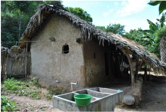
Figura 42 Tipología de vivienda vernácula, materiales bajareque, arcilla, madera. Fotografía de edaso (Caserío El Coco, Municipio de San Juan Ermita, Chiquimula 2015)
