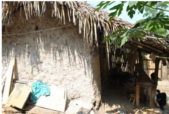
Figura 51 Tipología de vivienda vernácula, materiales bajareque, arcilla, madera, palma. Fotografía de edaso (Caserío El Coco, Municipio de San Juan Ermita, Chiquimula 2015)
