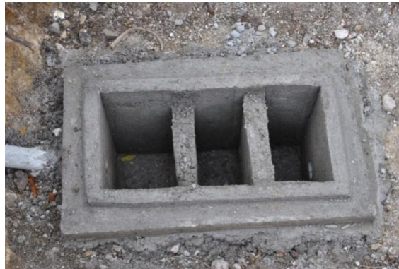
Figuras 89, 90, 91, Sistema de Tratamiento de Aguas Grises Fotografía de edaso (Aldea Minas Arriba, Municipio de San Juan Ermita, Chiquimula 2015)
