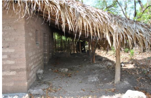
Figura 59 Tipología de vivienda construida con: cimiento de piedra, adobe, madera, y cubierta de palma. Fotografía de edaso (Caserío El Coco, Municipio de San Juan Ermita, Chiquimula 2015)
