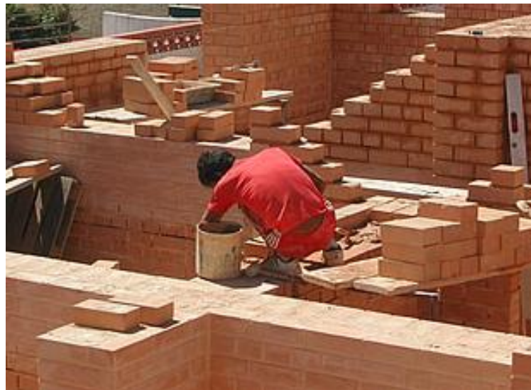
Figura 9 Uso de ladrillo ecológico. Fotografía de http://www.oskamvf.com/bloques_%20de_tierra_comprimida.html
