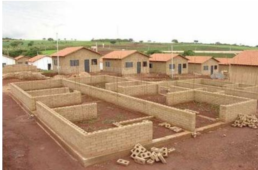
Figura 15 Construcción de viviendas con ladrillo ecológico. Fotografía de http://www.sistemasdeconstruccionecologicos.com/ladrillosecologicos.htm (Buenos Aires Argentina 2011)
