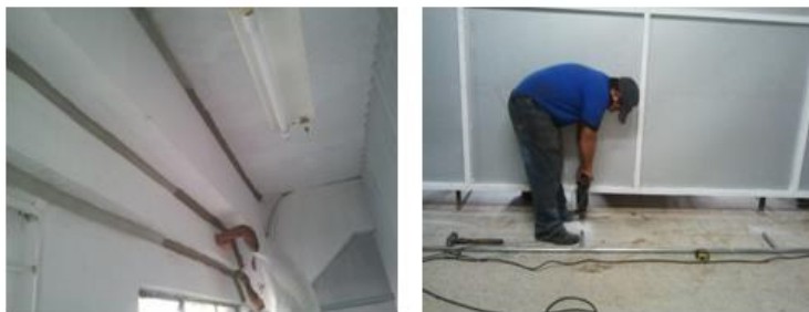
Figura 34. Elaboración de curva sanitaria y topes
