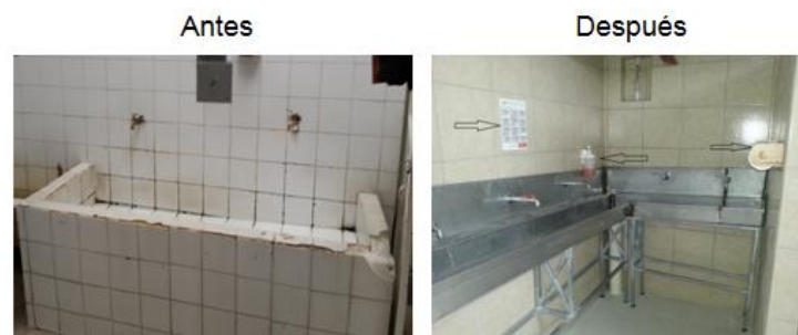
Figura 39. Renovación de lavamanos servicio sanitario
