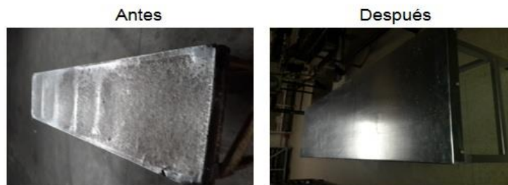
Figura 48. Renovación de equipo del Área de Empaque
