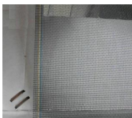
Figura 31. Colocación de malla mosquitera
