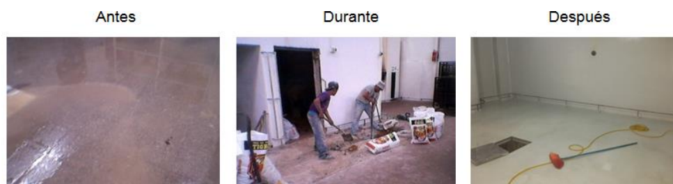
Figura 40. Construcción de drenajes
