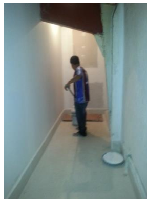
Figura 30. Pintado de paredes
