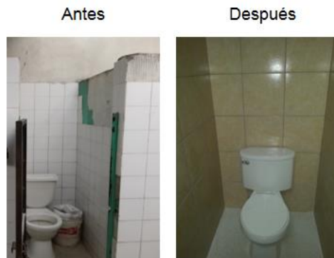
Figura 38. Cambio de azulejos del servicio sanitario
