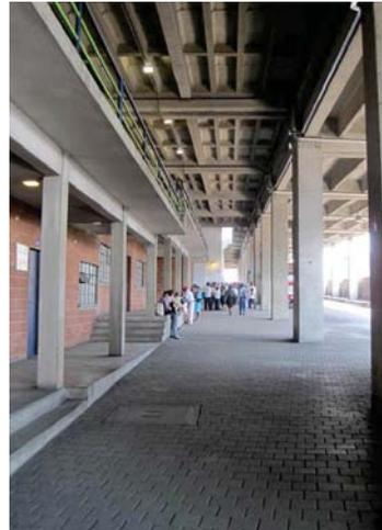
Losa nervada, columnas y vigas de concreto, paredes de las áreas privadas de ladrillo.
