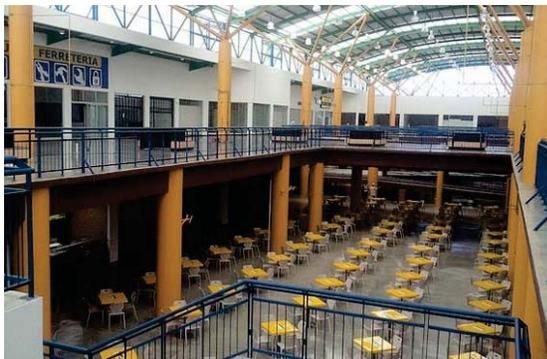
Columnas pata de gallo de acero recubiertas con materiales prefabricados.
