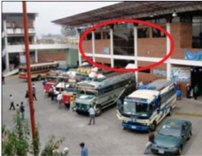
Muros de ladrillo, vigas y columnas de concreto.
