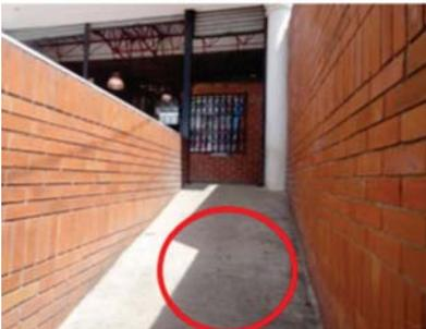
Rampas de concreto con un acabado con textura rugosa para evitar accidentes.
