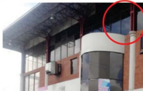
Columnas de concreto con estructura metálica anclada al final para poder cargar la estructura metálica de la cubierta.
