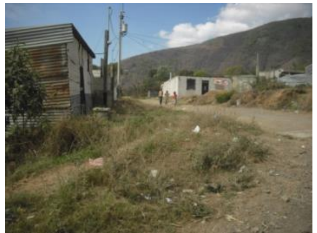
Fotografía 4 En esta se observa una vivienda hecha de madera y lámina, un poste de alumbrado público, la calle de terracería y basura en lotes deshabitados. Fuente Propia
