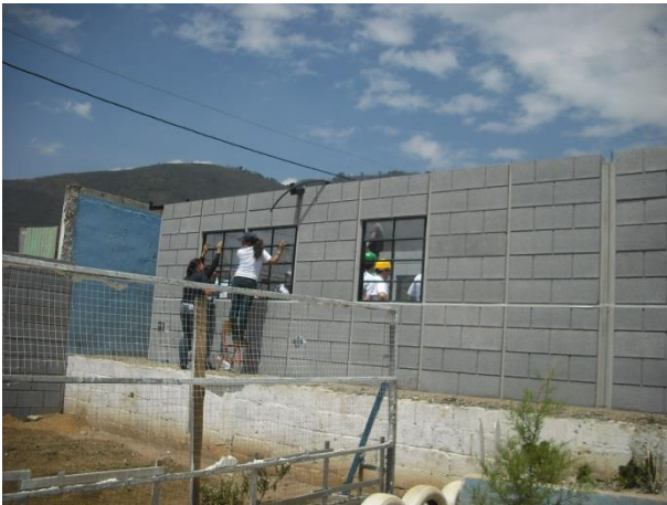
Fotografía 33 Construcción de Aulas.
