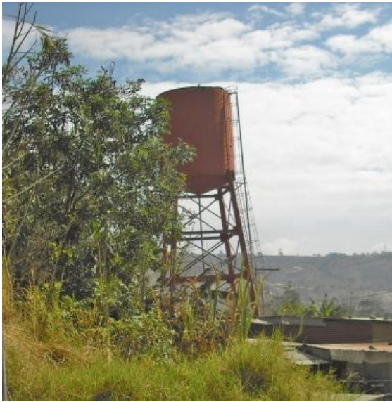
Fotografía 1 Vista del tanque elevado existente, pero no funcional, Fuente Propia
