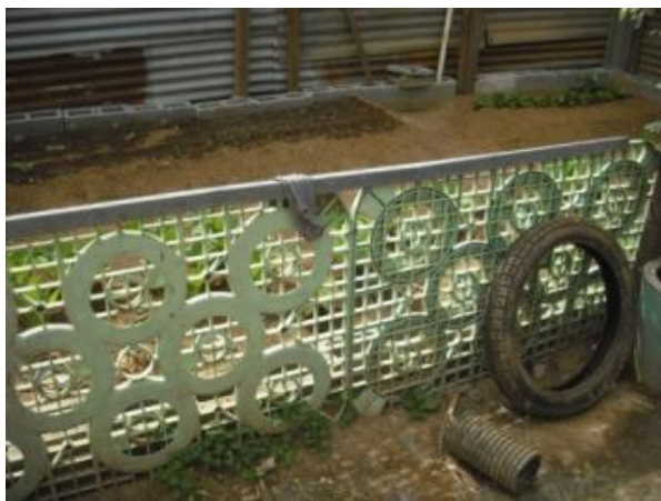
Fotografía 8 En esta imagen se observa la improvisación de un muro perimetral con partes de tarimas plásticas. Fuente Propia.
