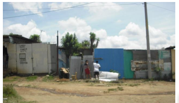
Fotografía 5 En esta se observa a una familia construyendo su vivienda de Madera y Lamina y los drenajes que corre sobre la calle. Fuente Propia
