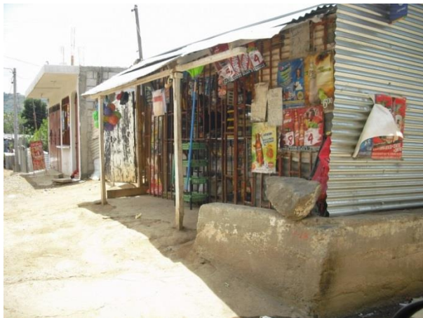
Fotografía 11 En esta imagen se observa una tienda instalada bajo una construcción de madera y lámina. Fuente Propia
