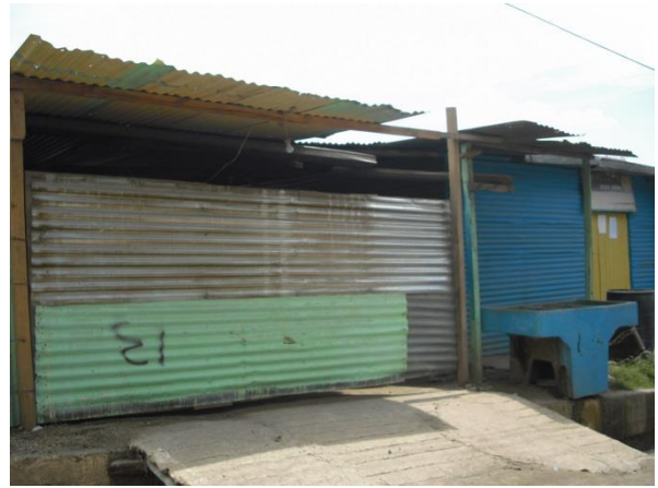
Fotografía 9: Imagen de Viviendas construidas con madera y lámina, se observa la pila de una vivienda al frente, a falta de tonel el camión llena la pila con agua. Fuente Propia.
