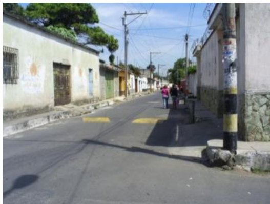
Fotografía 19 sobre la 7ª. Calle y 11 avenida zona 1, Fuente Propia.
