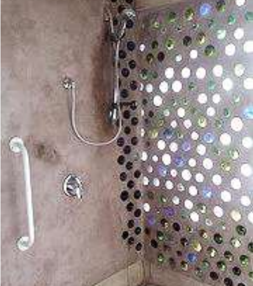
Utilización de materiales reciclables, en este caso fondos de botellas de vidrio.
