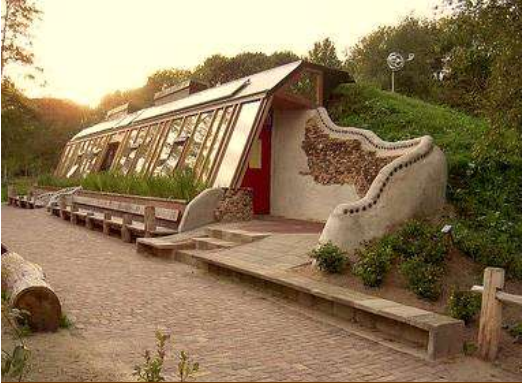
Proyección Climática, vitrales para retener el calor del sol en un clima frío.
