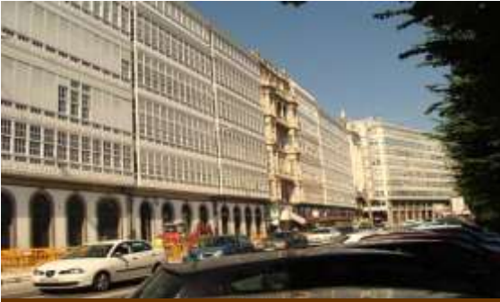
Las galerías (balcones y ventanas acristaladas) de La Coruña, un típico ejemplo del uso de la insolación para la calefacción natural de las viviendas en invierno
