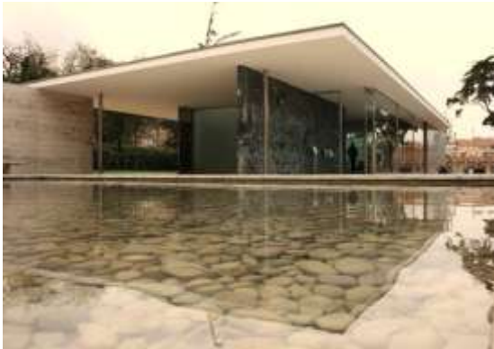
Pabellón de Alemania en la Exposición Internacional de Barcelona (1929), Arq. Ludwig Mies van der Rohe
