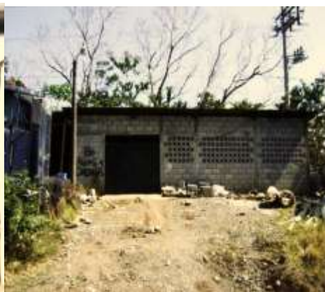
Bodega de Aguas y Drenajes Fuente: Personal
