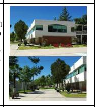
El Auditorio (G), este edificio es similar a la planta alta del modulo de enseñanza (B), debido a que está formado por marcos estructurales en los cuales las vigas están con cierto grado de inclinación esto debido a que la losa maciza bidireccional que sostienen es a dos aguas, los muros de cerramiento no son de carga por lo que están levantados con un sistema de ladrillo y block pineado.
