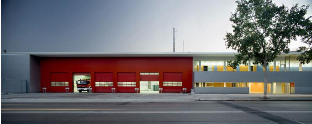
Imagen 21, Estación de Bomberos de Mataró , Fuente, http://www.franconiarchitects.com/ día de consulta 10 enero del Año 2016
