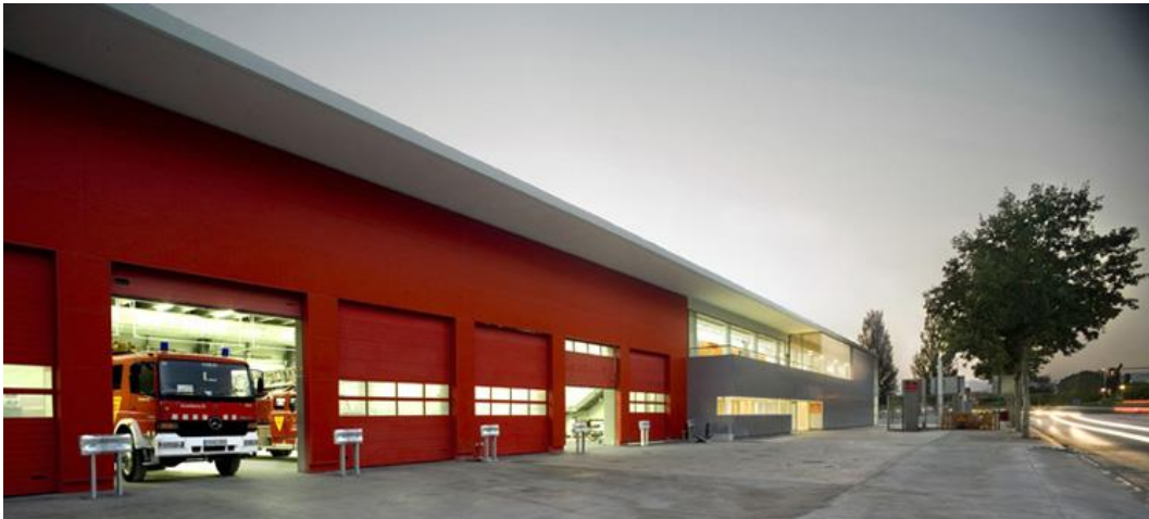
Imagen 22, Estación de Bomberos de Mataró , Fuente, http://www.franconiarchitects.com/ día de consulta 10 enero del Año 2016
