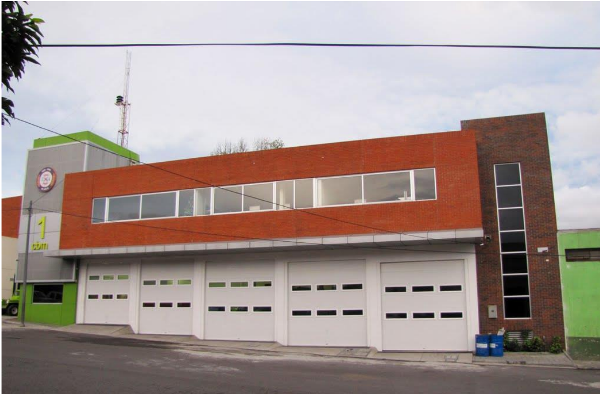
Imagen 19, Estación de Bomberos Central, Fuente: Flavio Quijivix Año 2010
