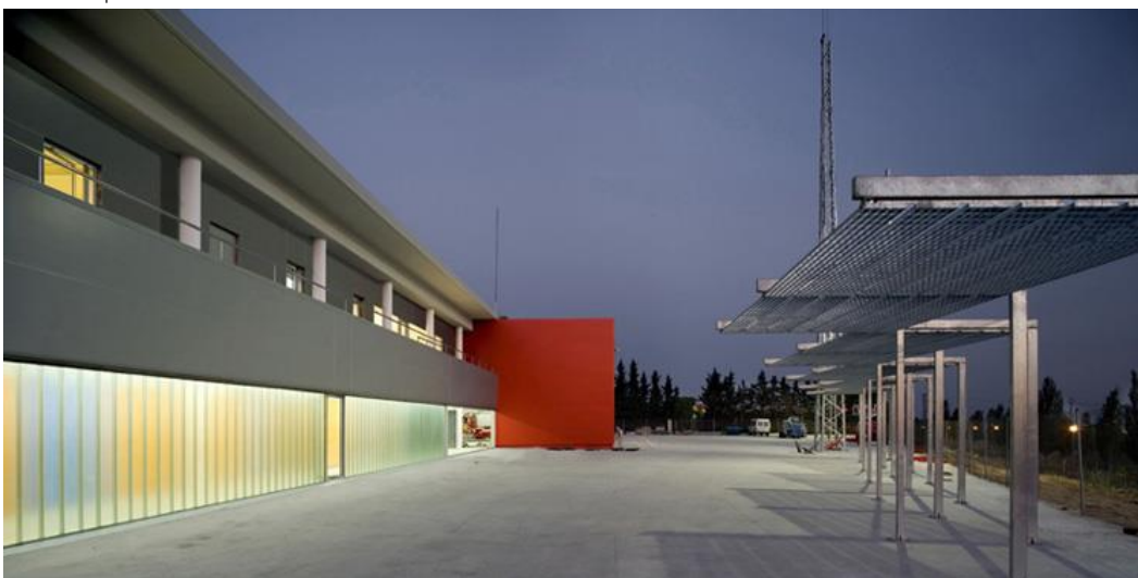
Imagen 23, Estación de Bomberos de Mataró , Fuente, http://www.franconiarchitects.com/ día de consulta 10 enero del Año 2016
