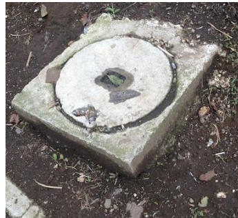
Imagen 35. Acometida de agua potable, Fuente: José Somoza. Año: 2013
