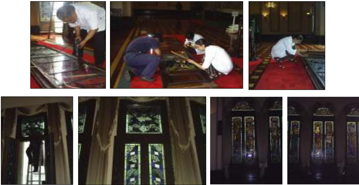
Fotografía 20. Proceso de montaje de los paneles restaurados, detalles
