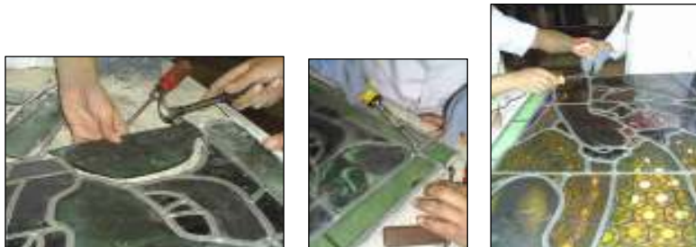
Fotografía 17. Colocación de la pieza faltante del vitral "El Quetzal" y el panel 2 del vitral PAX
