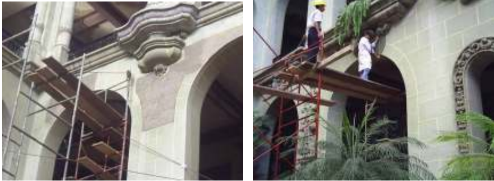
Fotografía 23. Paredes de patio externo, área en proceso de re sanación.
