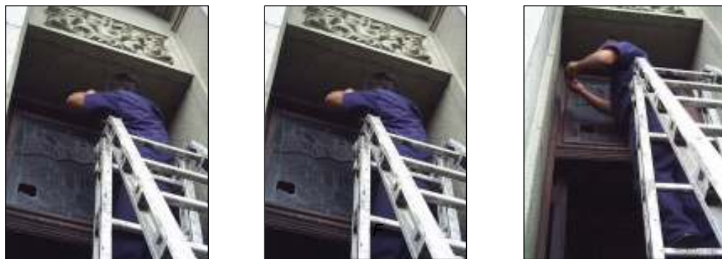
Fotografía 6. Retiro de tornillos para desmontar el vitral “El Quetzal”
