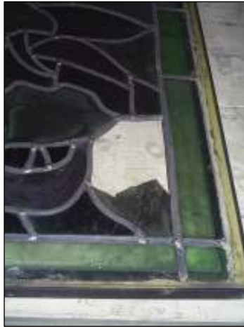
Fotografía 4. Vitral "El Quetzal", detalle, pieza fracturada y con perdida.
