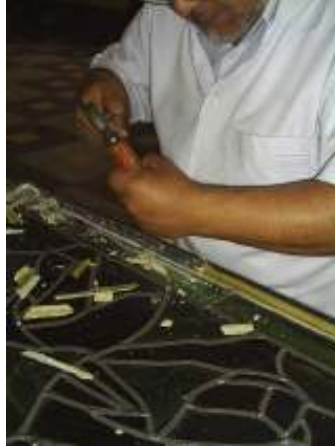
Fotografía 10. Eliminación del mastic del vitral "El Quetzal"
