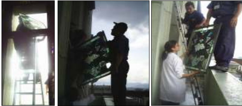
Fotografía 7. Retiro del vitral “El Quetzal”
