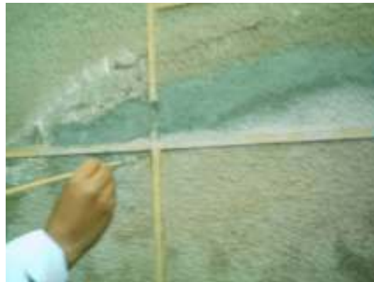
Fotografía 21. Paredes de patio interno.
