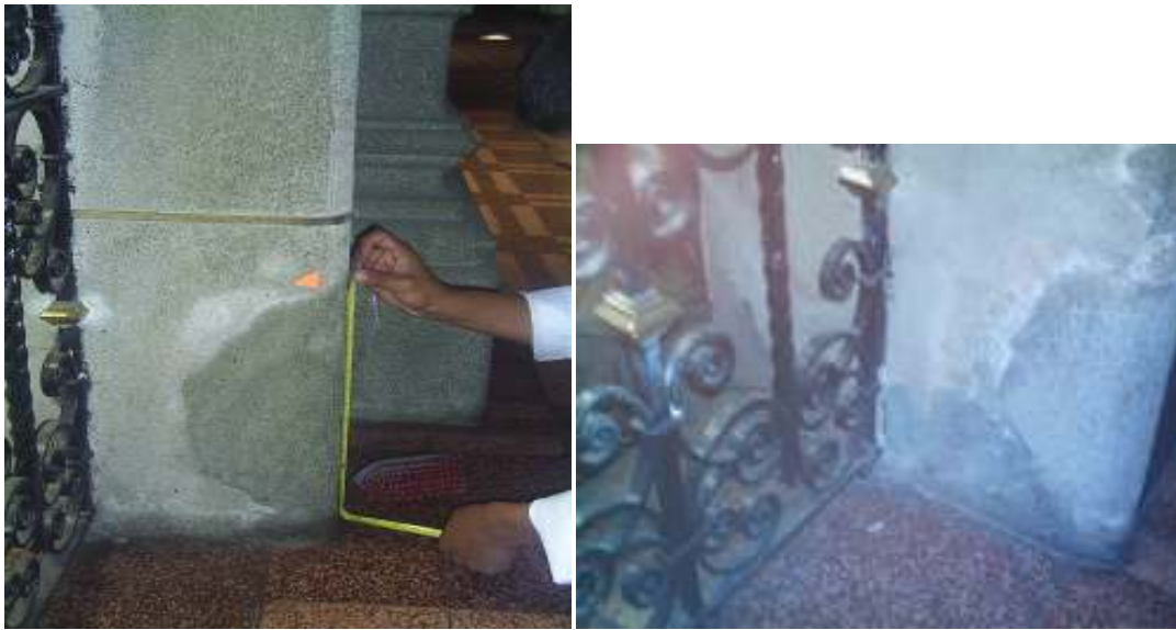
Fotografía 24. Paredes de patio externo, área en proceso de re sanación
