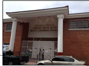
ESCUELA No 810 UBICADA AL OESTE DEL TERRENO .
