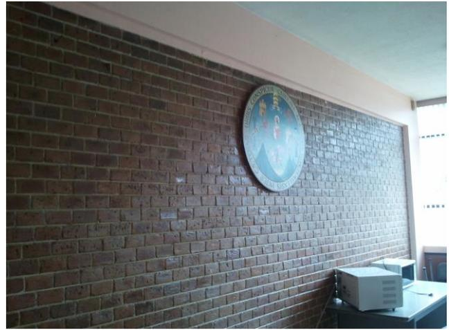
**Fotografía No 14, No 15.** Se puede observar cómo se usa el ladrillo para el cerramiento de las Paredes las cuales sirven de relleno y no soportan cargas.
