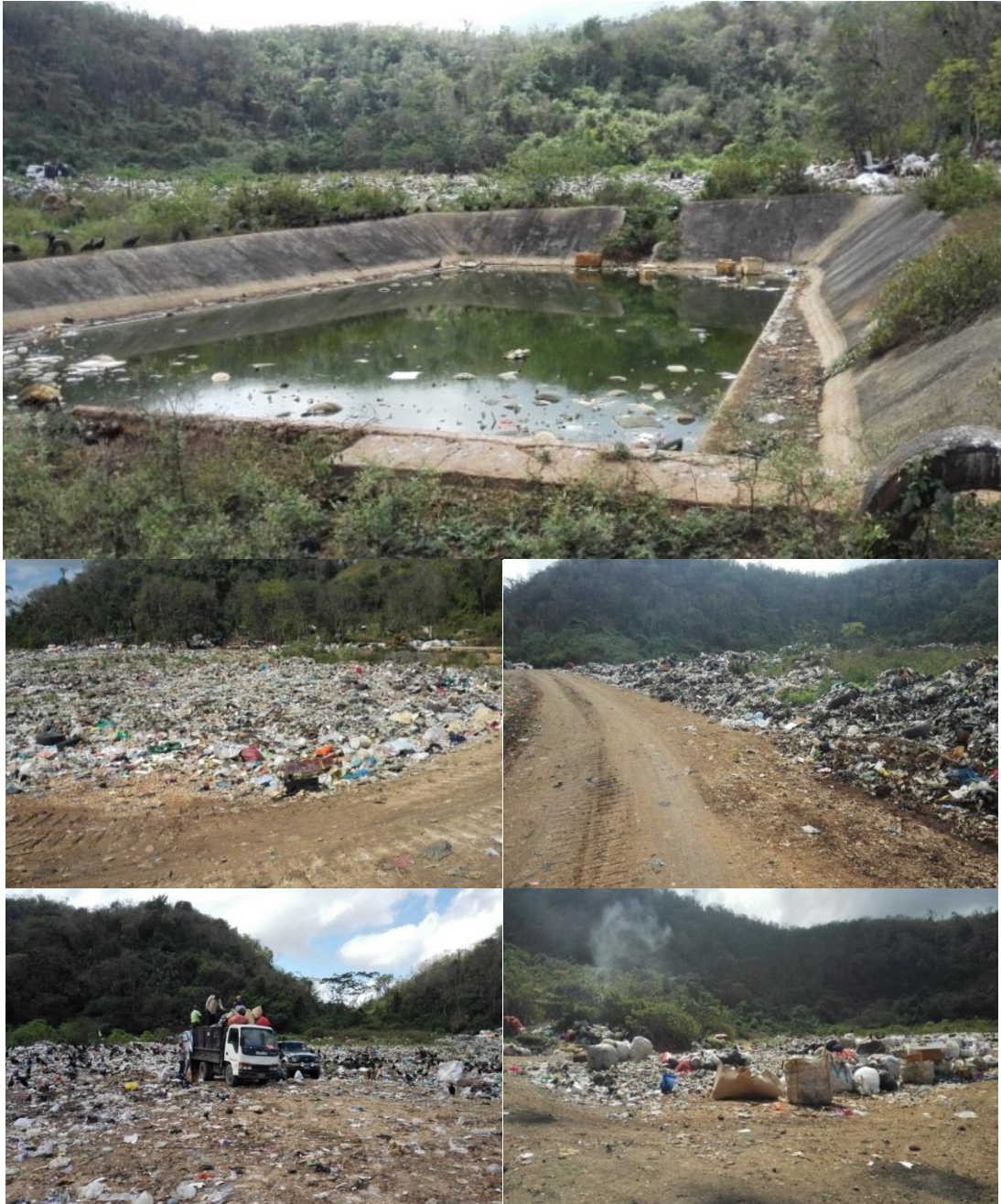
Figura 2. Estado actual del vertedero municipal
