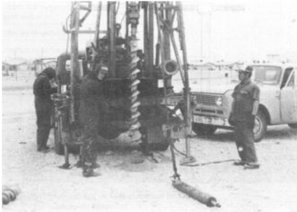
Figura 14. Perforación con barrenas de raspado continuo
