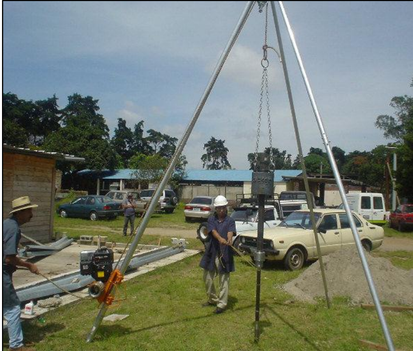
Figura 32. Prueba de penetración estándar en ejecución
