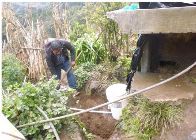
Figura 65. Construcción del primer agujero para el filtrado de aguas grises
