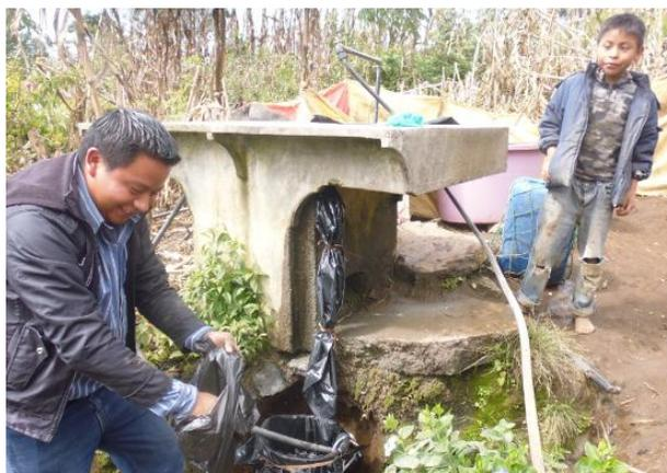
Figura 66. Colocación de los materiales al primer agujero de filtrado.
