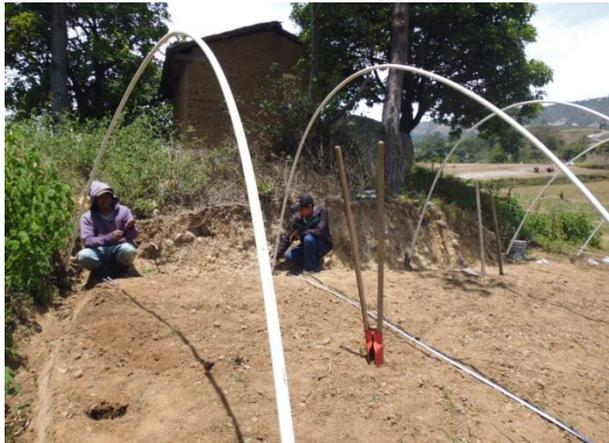
Figura 55. Instalación de arcos en el macrotúnel
