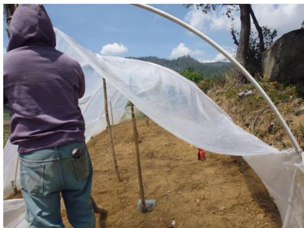
Figura 56. Colocación de polietileno a la estructura
