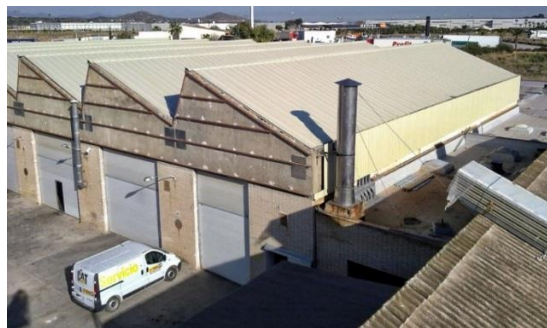
Figura 44. Techo dientes de sierra
