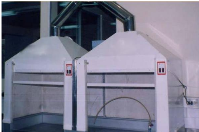
Figura 55. Campana de extracción de gases
