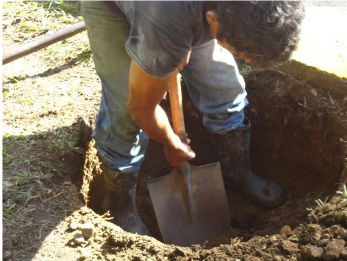
Figura 42. Extracción de calicatas al lado del pavimento de la Universidad de San Carlos de Guatemala
