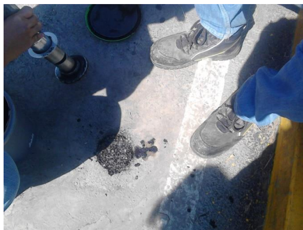
Figura 37. Relleno de los hoyos producidos por la extracción
