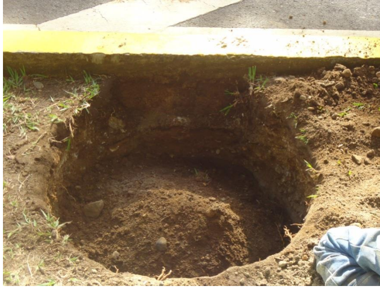
Figura 35. Ejemplo de una calicata terminada
