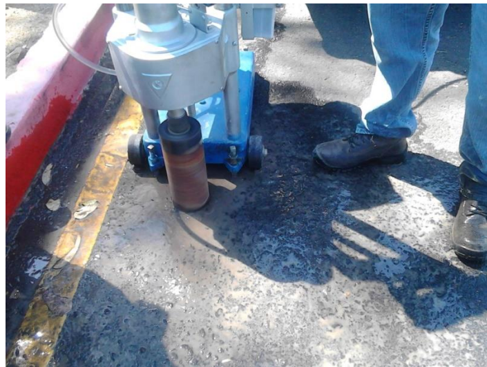
Figura 43. Extracción de núcleos del pavimento de la Universidad de San Carlos de Guatemala
