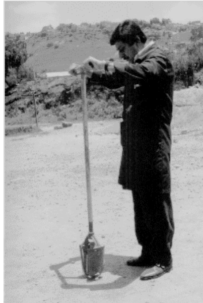
Figura 10. Muestreo utilizando pala excavadora
