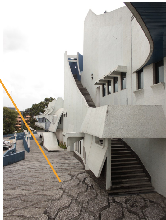
Imagen 16. Vista de circulaciones exteriores, toma propia 2015.
