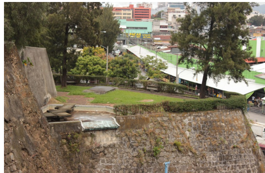
Imagen 11. Vista de plataformas tratadas, toma propia 2015.
