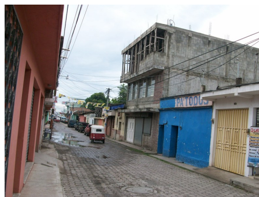
Imagen 6: Construcción vivienda de block, imagen propia (2015).
