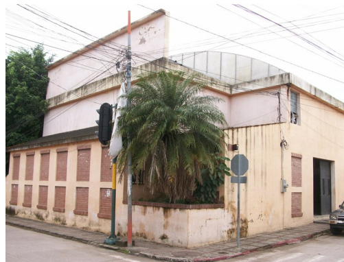
Imagen 5: Construcción de ladrillo a gran escala, imagen propia(2015).
