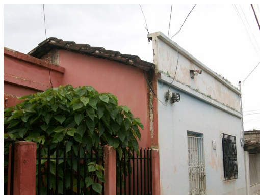
Imagen 3: Vivienda de adobe y falsa fachada, imagen propia (2015).
