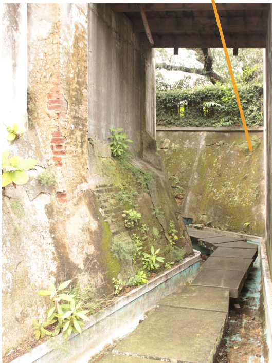
Imagen 18. Vista de detalle en mirador, toma propia 2015.
