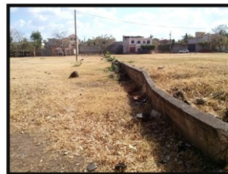
Vista de instalaciones Eléctricas
