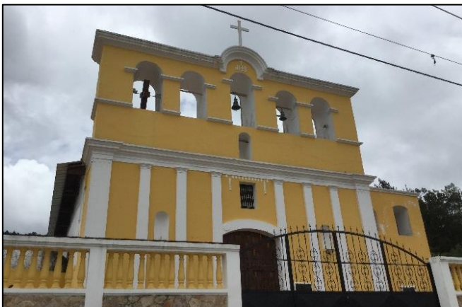
Fotografía No. 9, Iglesia Católica Antigua de San José Pinula, Guatemala Fuente: Propia. Año 2016
