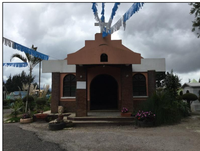
Fotografía No. 13, Capilla del Cementerio Municipal de San José Pinula, Guatemala Fuente: Propia. Año 2016
