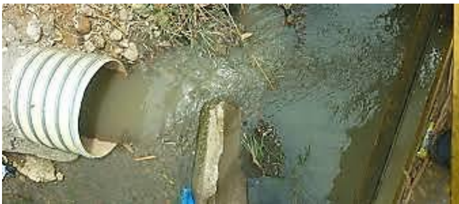
Figura 17. Aguas residuales industriales
