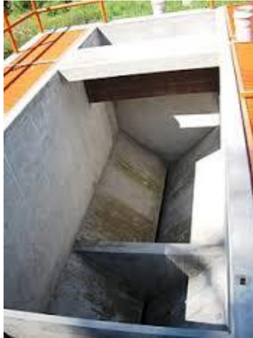
Figura 23. Tanque Imhoff
