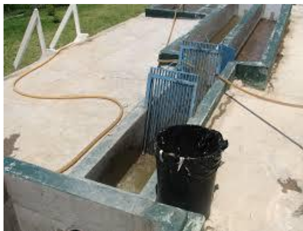
Figura 19. Desarenador actual de la planta de tratamiento de aguas residuales
