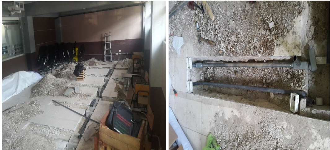
Figura 25. Instalación de tuberías en laboratorio 014
