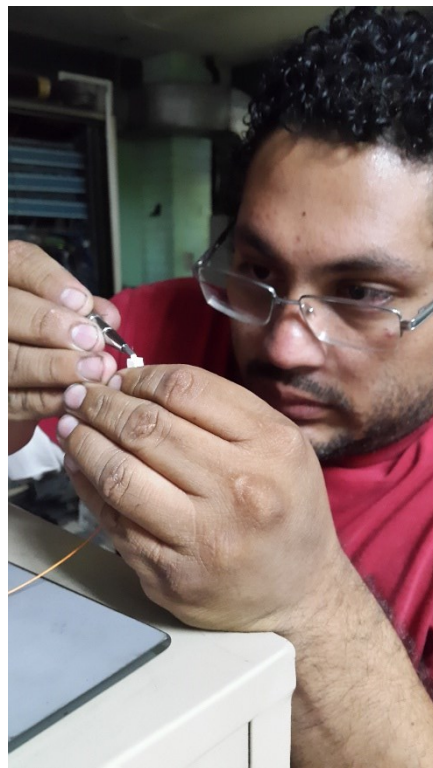
Figura 13. Corte de sobrante de fibra óptica del conector
