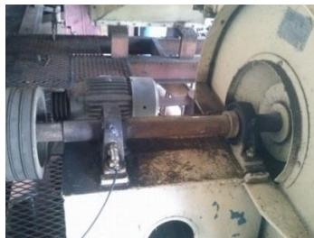
Figura 26. Ventilador inducido de horno punto 3H
