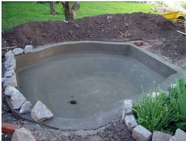
Figura 8. Estanque de concreto
