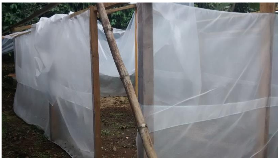
Figura 59: Construcción de las paredes laterales del vivero comunitario
