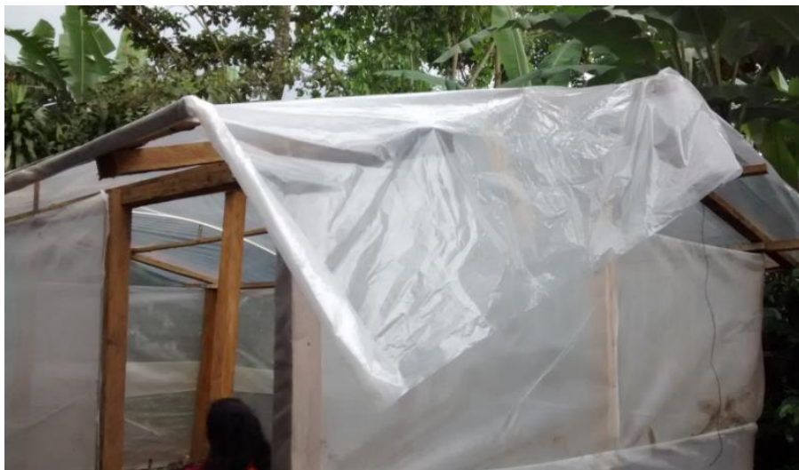
Figura 58. Construcción del techo del vivero comunitario
