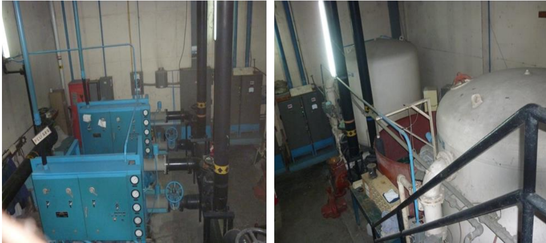
Figura 17. Instalación de bombas centrífugas
