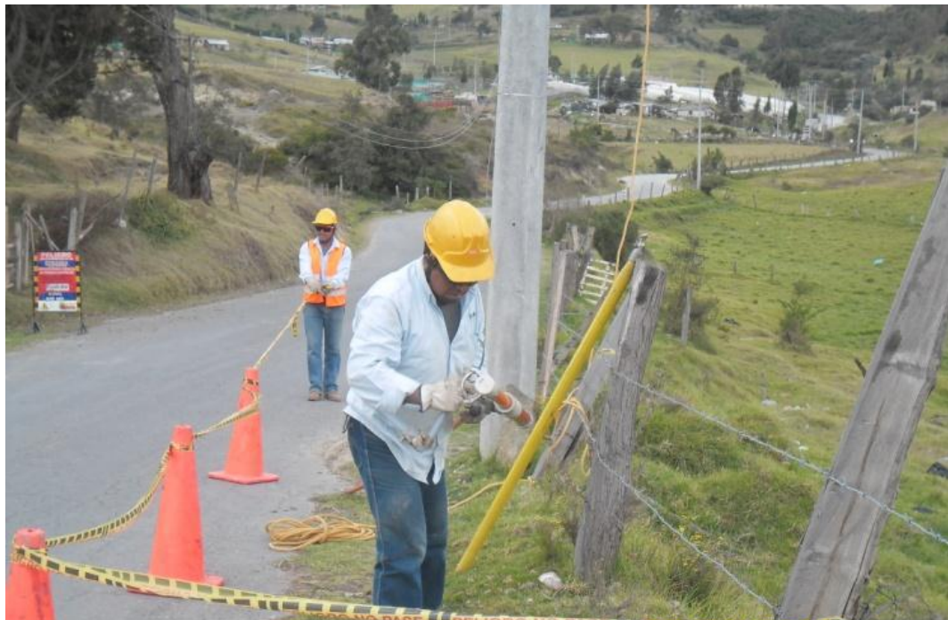
Figura 14. Señalización de trabajo
