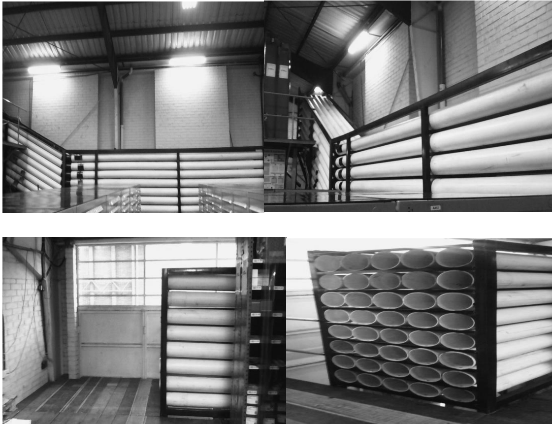
Figura 69. Montaje final del diseño modificación de mangueras
