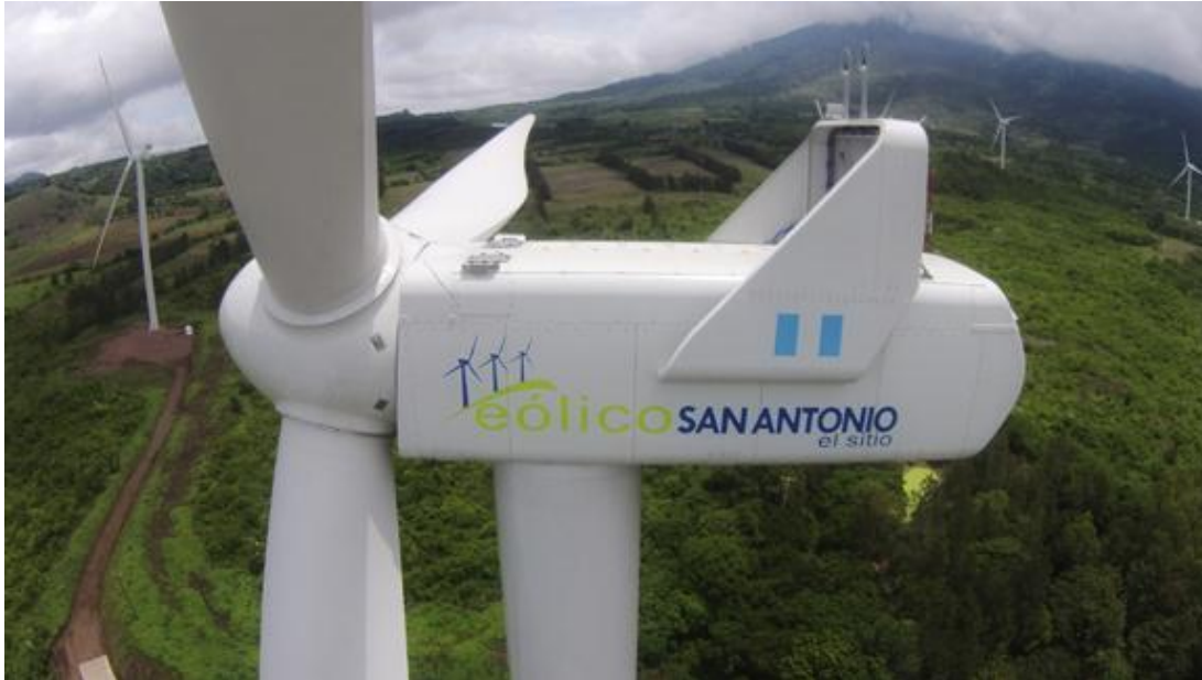
Figura 31. Parque eólico San Antonio El Sitio
