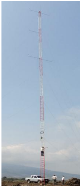
Figura 26. Estación de medición tipo celosía a 51 metros de altura
