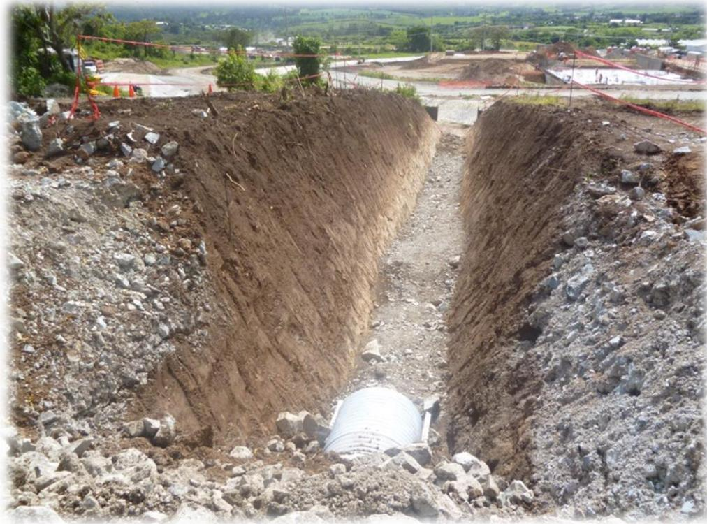
*Imagen No. 8: Excavación de Zanjas<sup>30</sup>*
