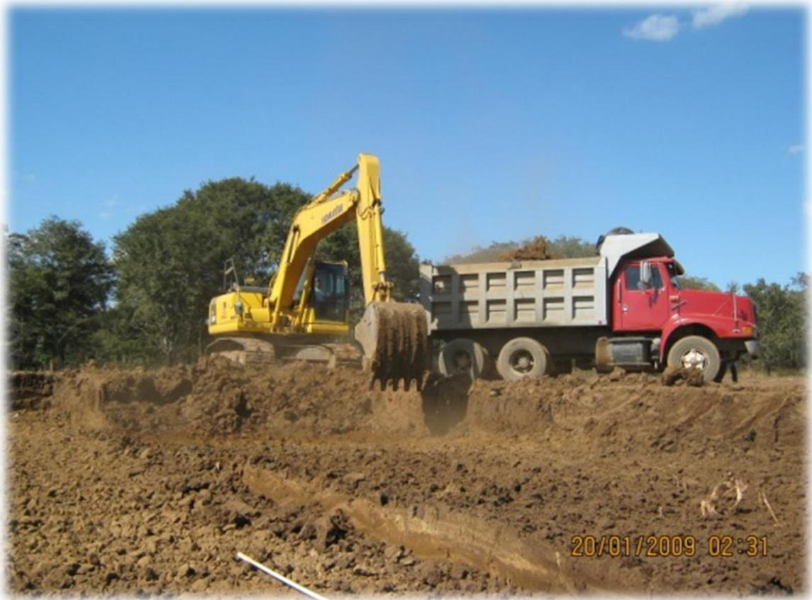
*Imagen No. 4: Carga de Material de desperdicio<sup>24</sup>*
