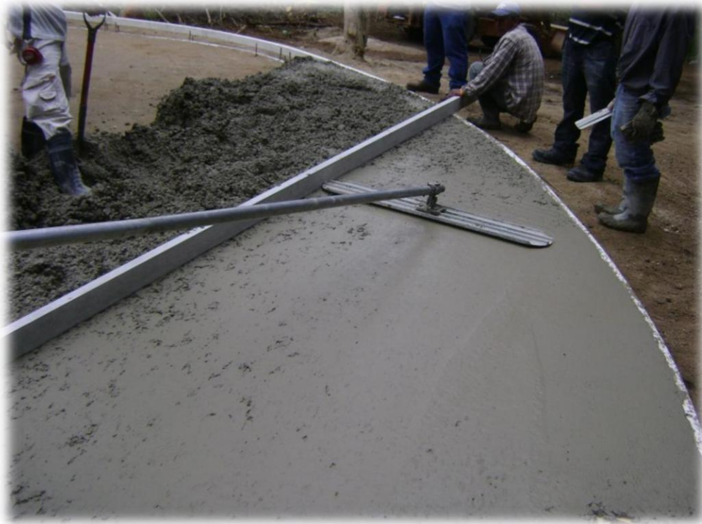
*Imagen No. 12: Fundición Cool de Sac en Concreto <sup>36</sup>*
