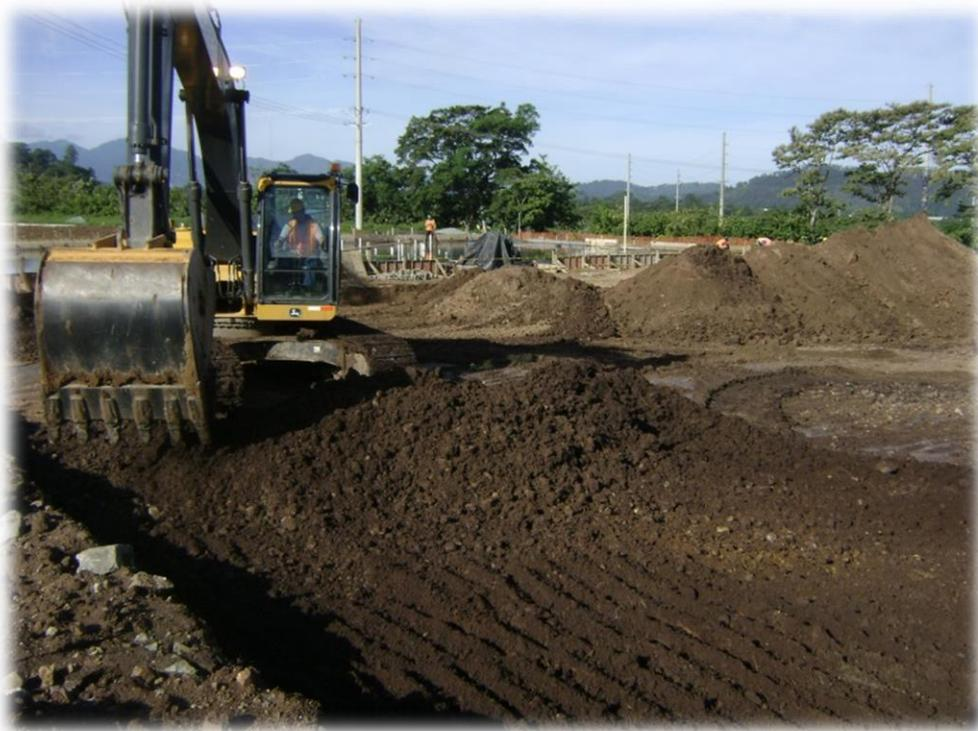
*Imagen No. 6: Corte y vaciado en plataformas<sup>27</sup>*
