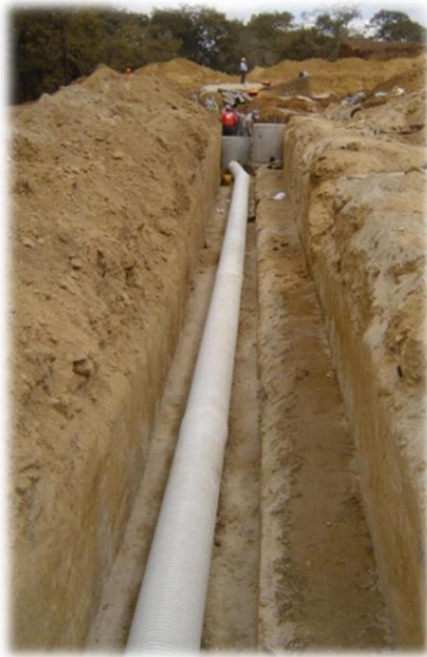
*Imagen No. 9: Colocación de Tubería*<sup>31</sup>
