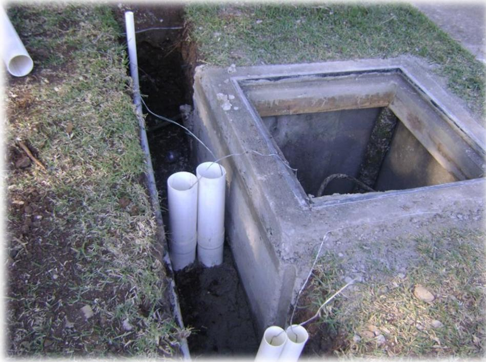
*Imagen No. 11: Caja tipo H, para instalaciones Eléctricas* <sup>33</sup>
