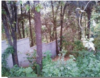
MURO PERIMETRAL ENTRE LA CANCHA POLIDEPORTIVA Y EL TERRENO.
