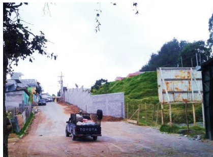
VISTA 1: LA CONEXIÓN EN EL MUNICIPIO SE REALIZA EN CADA UNA DE LAS CASAS DE HABITACIÓN, COLOCANDO CAJAS DE REGISTRO PARA SU FACTURACIÓN POSTERIOR.
