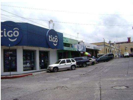
Construcción de Mixto block. Elaboración propia. Mayo 2014.
