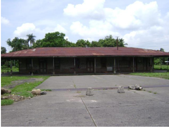
Construcción de madera y Lámina. Elaboración Propia Mayo 2014.
