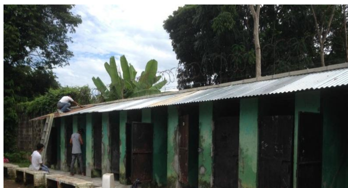
Fotografía No. 4. Arreglo de puertas, colocación de láminas nuevas.
