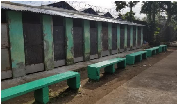
Fotografía No. 5. Arreglo de paredes y colocación de todas las puertas.
