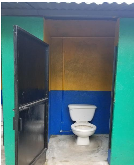
Fotografía No. 7 Baños Nuevos Colocados
