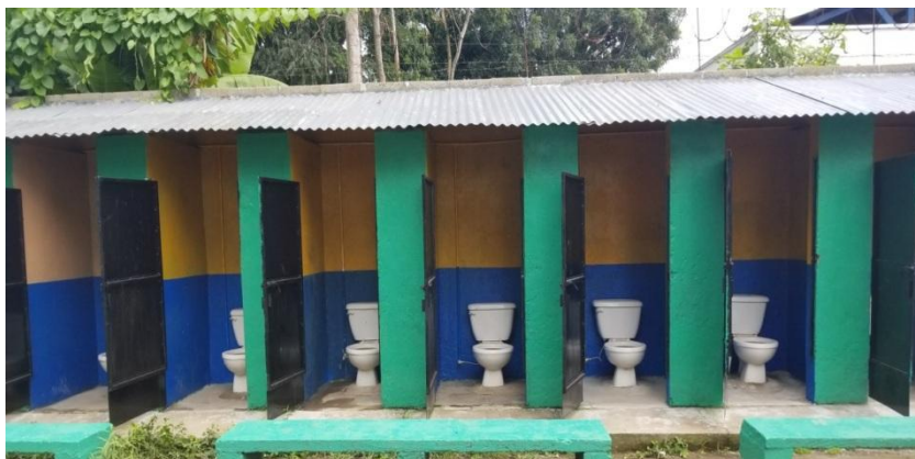
Fotografía No. 8. Servicios Sanitarios remodelados, láminas, puertas y paredes.
