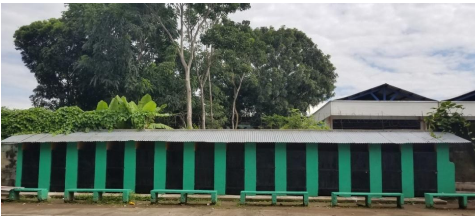
Fotografía No. 9. Servicios Sanitarios Remodelados Completamente.
