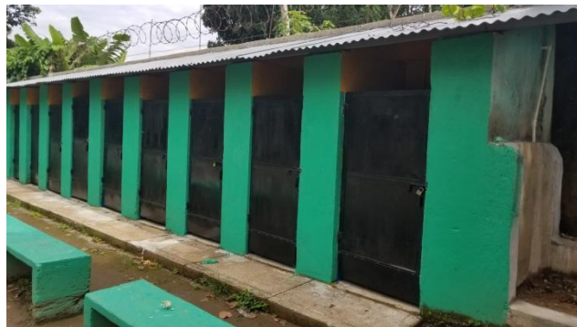
Fotografía No. 6. Pintura de las instalaciones.
