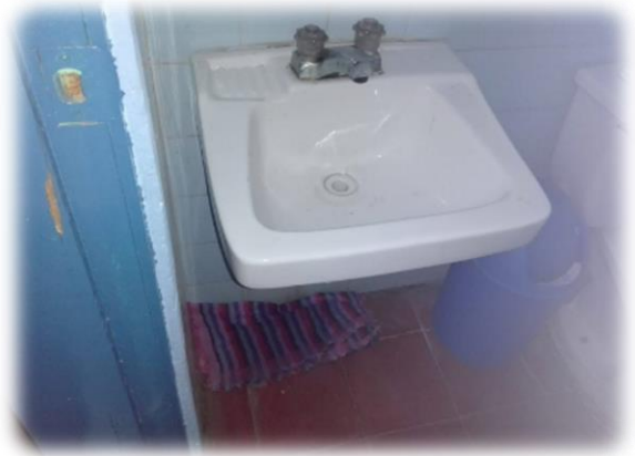
Instalación de lavamanos nuevo.
