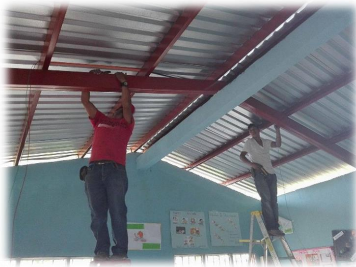
Proceso de cableado e instalación de flaponeras.
