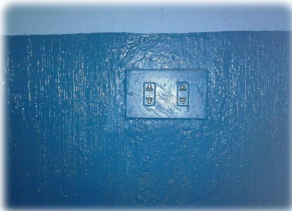
Cambio de tomacorriente.
