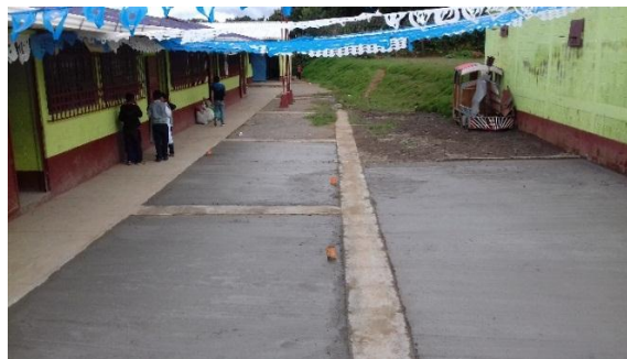
Fotografía 4. Finalizado de pavimentación.
