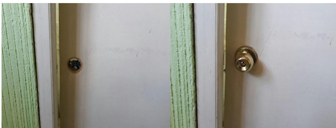
Fotografía 11. Colocación de chapa.
