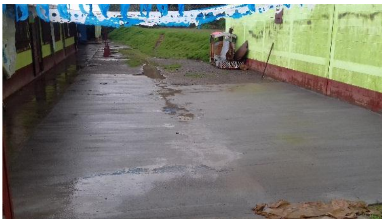
Fotografía 5. Obra ya finalizada.
