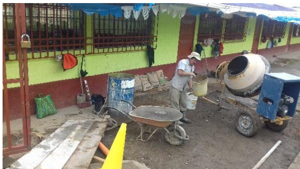
Fotografía 3. Trabajo de pavimentación.
