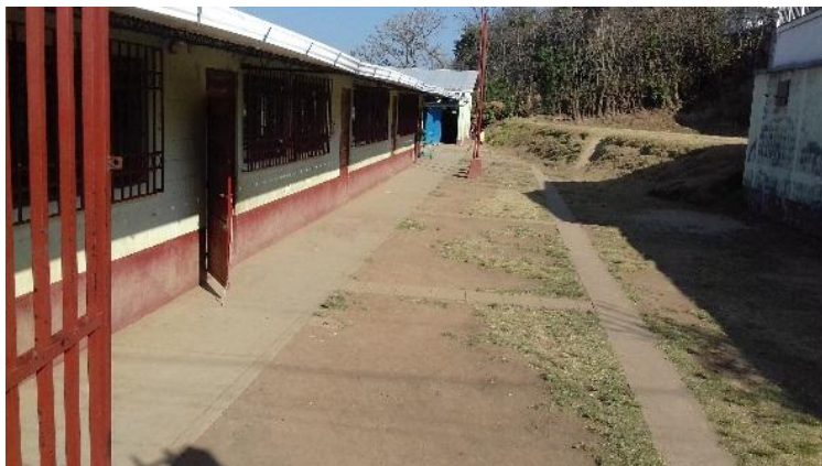
Fotografía 2. Estado inicial del patio.
