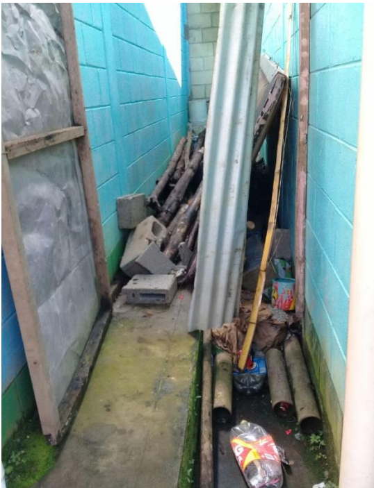
Estado Inicial del área para la bodega
