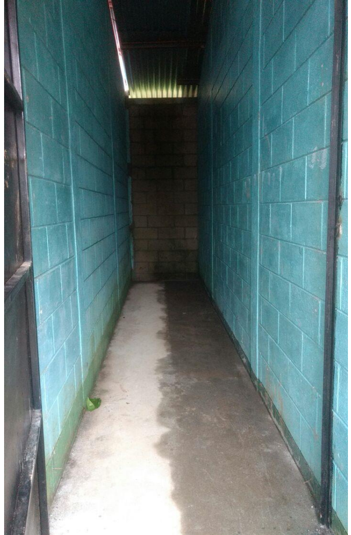
Construcción de Bodega finalizada
