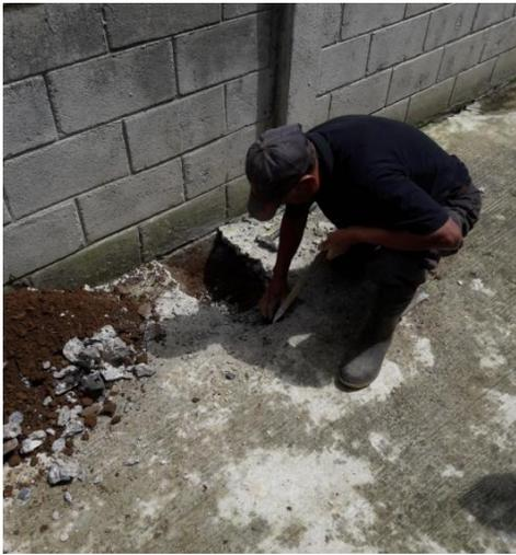
Trabajo de campo por parte del Fontanero Juan Sosa, realizando las canaletas y espacios necesarios para la futura conexión de la tubería hacia la candela y el drenaje principal.
