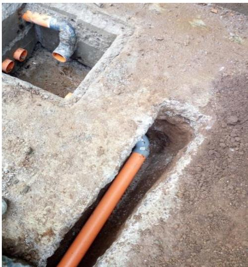
Instalación de nueva tubería en canaletas y cajas previamente hechas por el Fontanero Juan Sosa. La tubería incluye sifones para evitar el mal olor.
