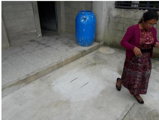
Supervisión del sellado con cemento de canaletas y caja de la nueva tubería.
