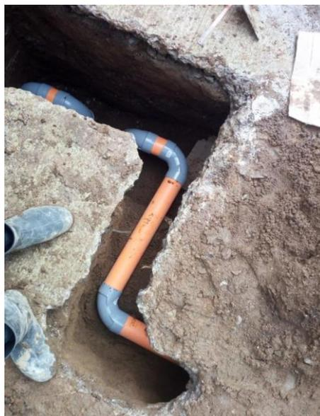
Instalación de nueva tubería en canaletas y cajas previamente hechas por el Fontanero Juan Sosa. La tubería incluye sifones para evitar el mal olor.
