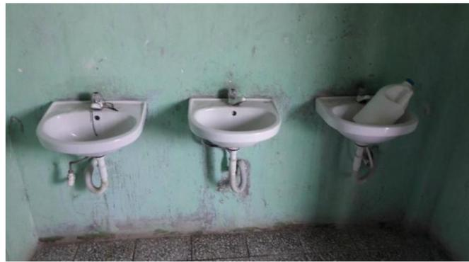
Lavamanos sin utilizar por falta de agua y tubería deficiente
