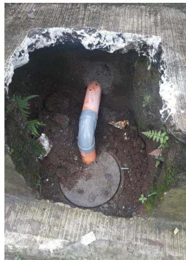
Instalación de nueva tubería en canaletas y cajas previamente hechas por el Fontanero Juan Sosa. La tubería incluye sifones para evitar el mal olor.
