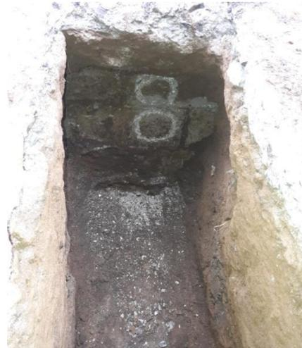
Trabajo de campo por parte del Fontanero Juan Sosa, realizando las canaletas y espacios necesarios para la futura conexión de la tubería hacia la candela y el drenaje principal.
