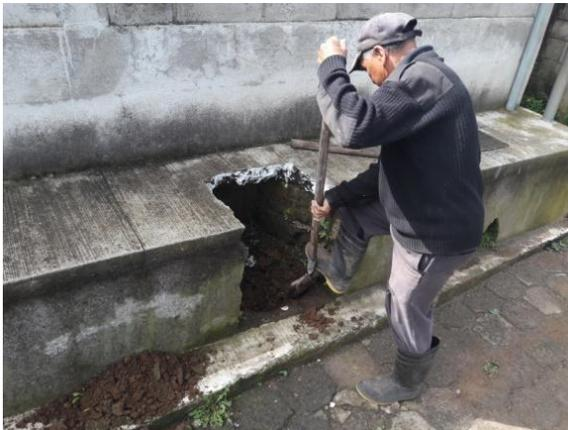
Trabajo de campo por parte del Fontanero Juan Sosa, realizando las canaletas y espacios necesarios para la futura conexión de la tubería hacia la candela y el drenaje principal.
