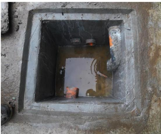
Instalación de nueva tubería en canaletas y cajas previamente hechas por el Fontanero Juan Sosa. La tubería incluye sifones para evitar el mal olor.
