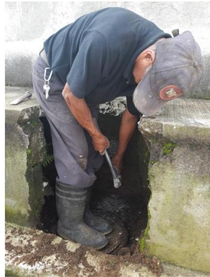
Trabajo de campo por parte del Fontanero Juan Sosa, realizando las canaletas y espacios necesarios para la futura conexión de la tubería hacia la candela y el drenaje principal.
