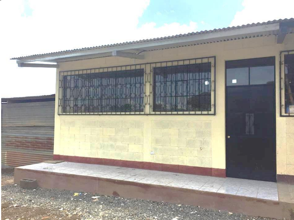
Finalización de la construcción del aula
