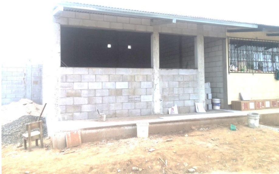
Continuación de construcción de proyecto. (Colocación piso)
