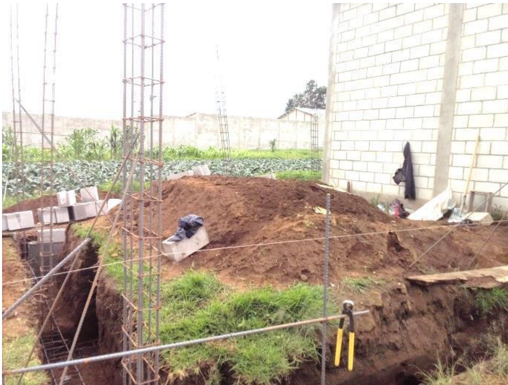
Inicio de Proyecto comunitario (elaboración de cimientos de construcción)
