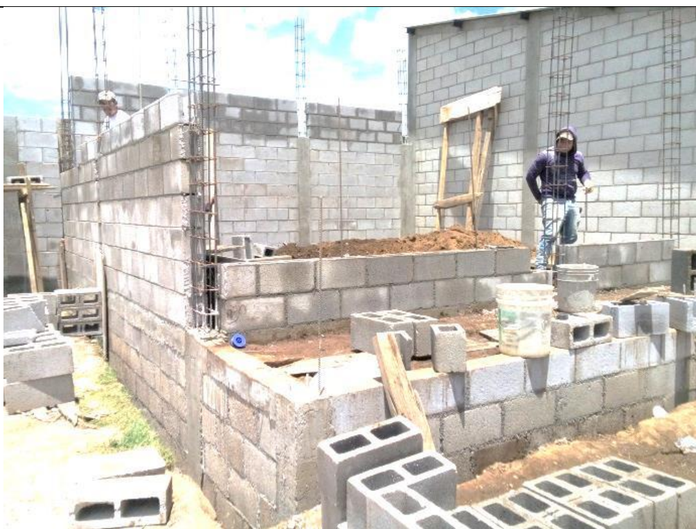
Continuación de construcción de proyecto. (Construcción de paredes)
