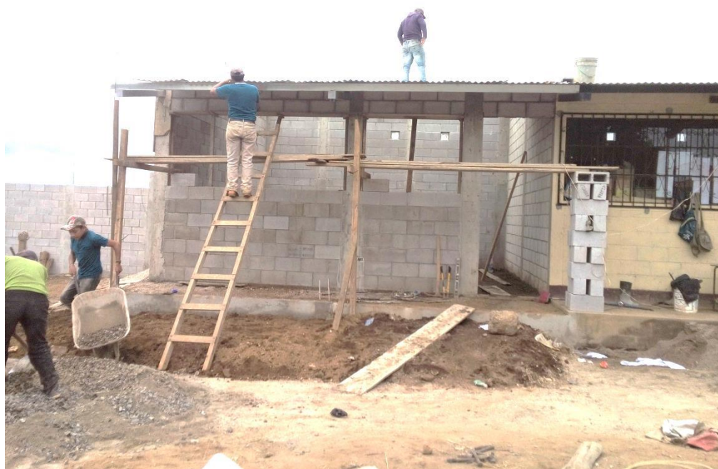
Continuación de construcción de proyecto. (Elaboración y colocación de techo)
