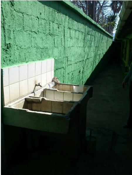
Estado de la pila al iniciar el proyecto, se observa que no hay ningún tipo de lavamanos y la pila está en muy mal estado.
