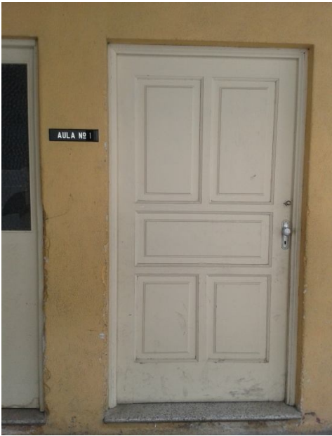
Foto No. 7: puerta única del salón de clases remodelado.
