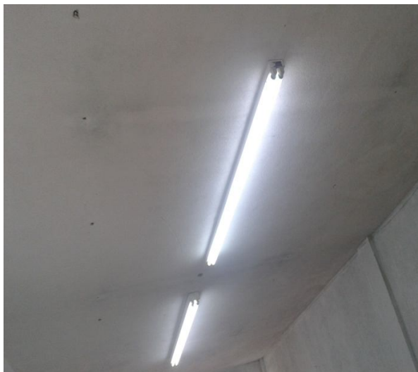
Foto No. 6: muestra el techo pintado de blanco para mayor luminosidad
