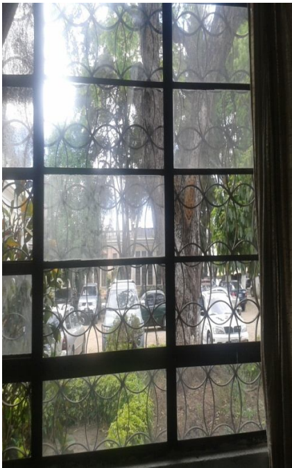
Foto No.9: se colocaron vidrios transparentes para dejar pasar mayor claridad
